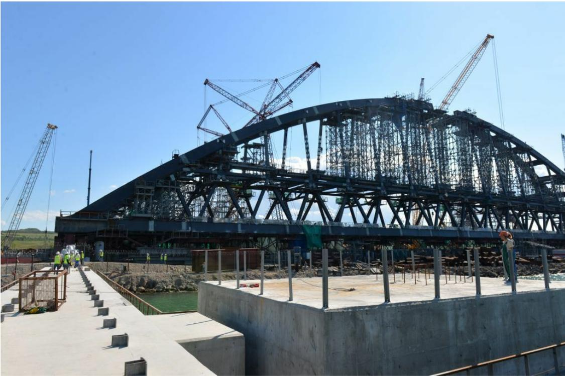
***Brückenbogen der Krim-Brücke wird an Land montiert
