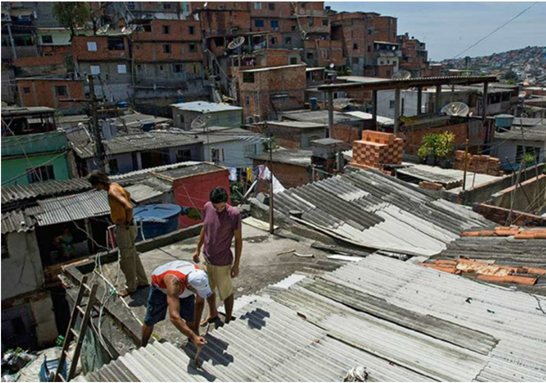
Montage einer Biogasanlage auf den Dächern der Favela da Paz.
