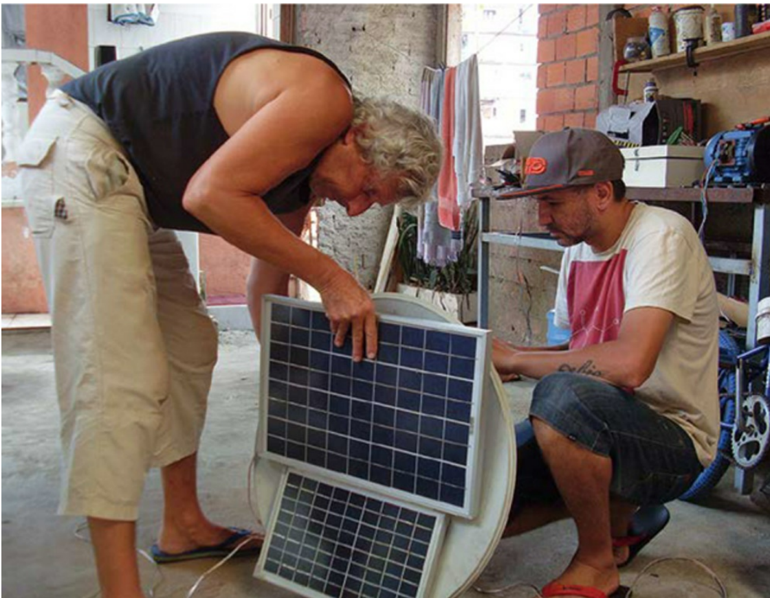
Fabio Miranda und Ulrich Stempel aus Deutschland (links) montieren solare Module auf eine im Schrott gefundene Satellitenschüssel in der Favela da Paz. Die Schüssel dient als bewegliche Halterung, damit die
