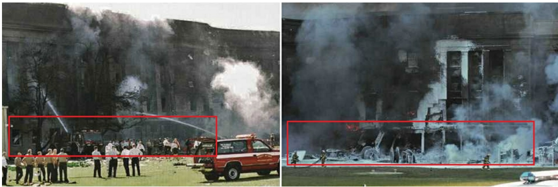
Bild 5: Links das Pentagon nach dem „Einschlag“ mit intaktem Erdgeschoss, Bild der US Navy (2). Rechts: später sind die Außenmauern weg, Bild der US Navy
