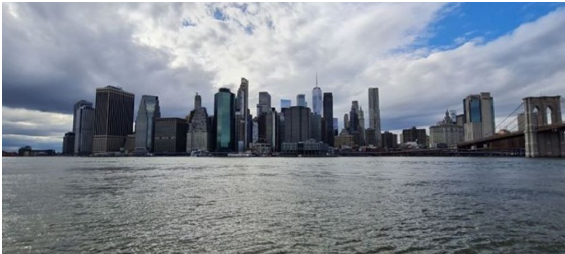
Blick auf Südost-Manhattan mit der Brooklyn Bridge rechts
